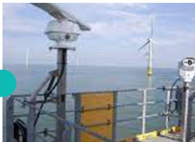
Un radar sera installé sur l'éolienne centrale. Les données récoltées seront analysées pour décrire plus finement les interactions entre la faune volante et les éoliennes.
